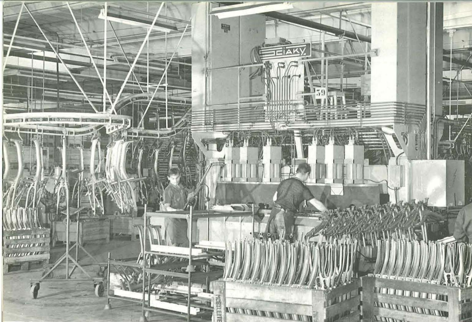
C'est une machine automatique multipoints qui assemble: le cadre-poutre, celui-ci avec le tube de direction et ce sous-ensemble avec le sous-ensemble arrière en une seule opération. Cette machine comporte un transfert automatique avec deux chariots porte-pièces. Ceux-ci indexés l'un derrière l'autre, suivent un parcours quadrangulaire, au cours duquel ils occupent successivement six stations.
